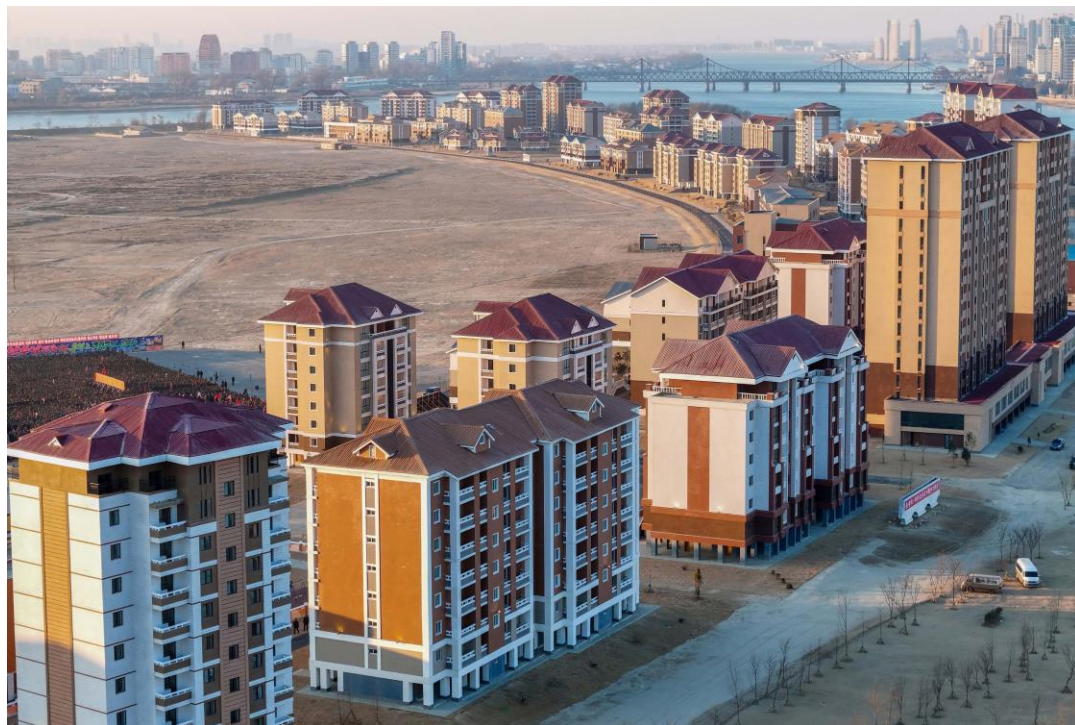
2024年12月竣工的平安北道灾区住宅
