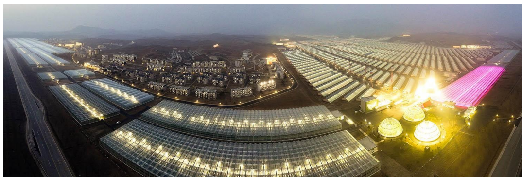
2024年3月，江东综合温室农场竣工投产。
