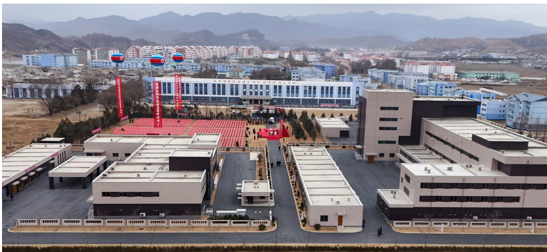
2024年12月，地方发展的第一个实体——成川郡地方工业工厂竣工投产。
