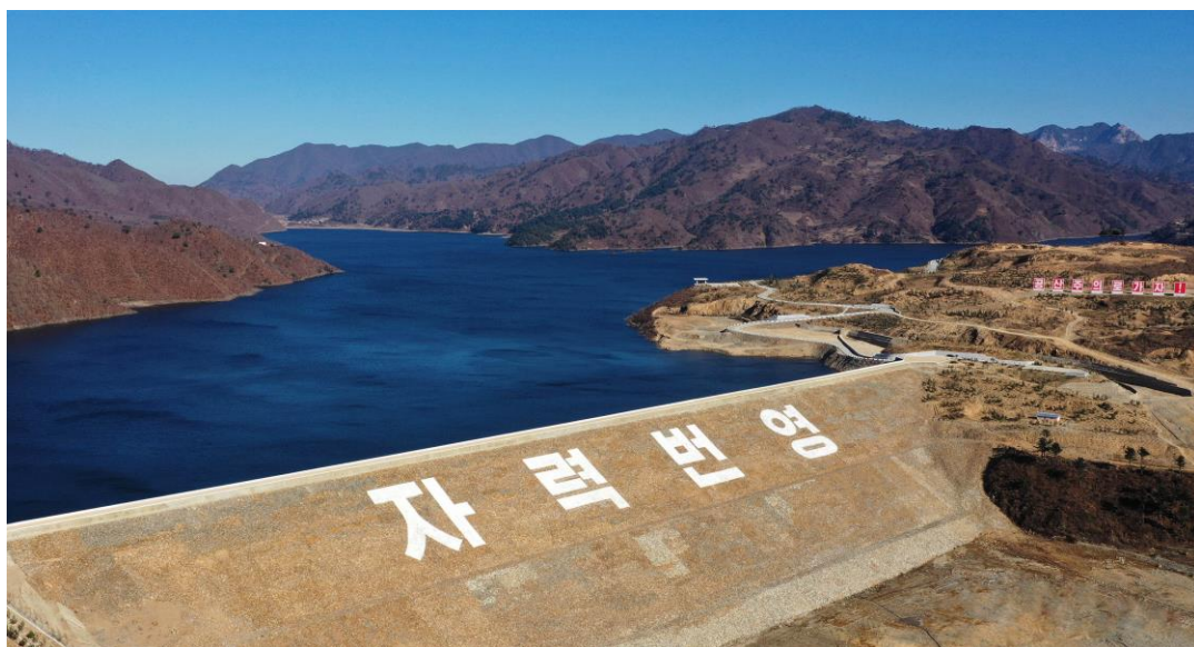
2024 年 12 月竣工的高城军民发电站
