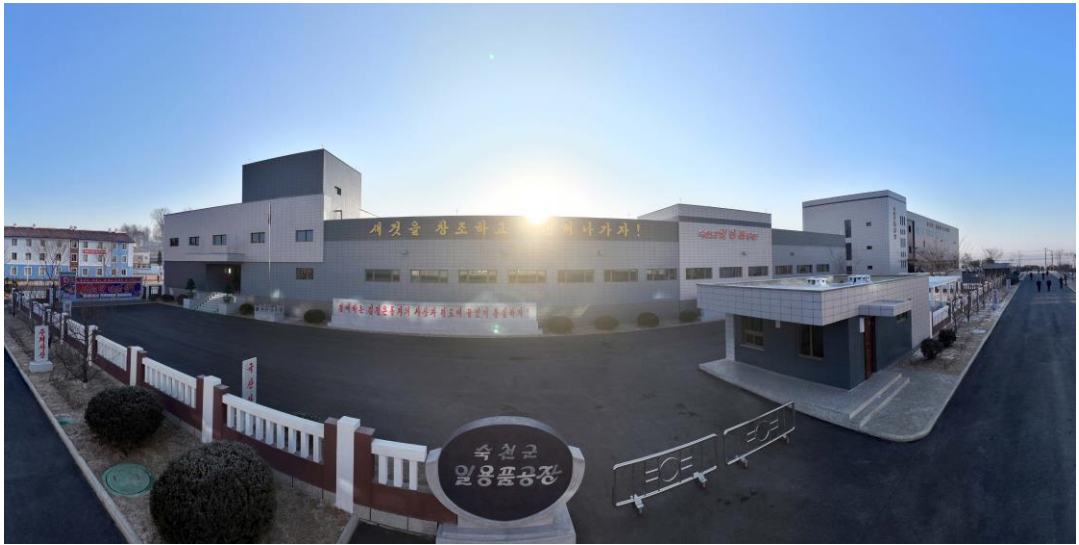
地方工业工厂在肃川郡落成。
