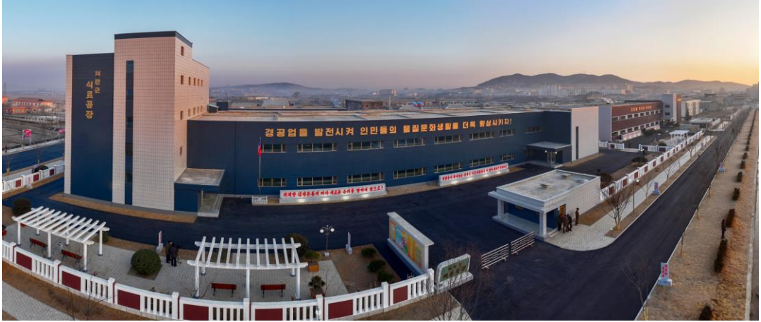
建立在载宁郡的地方工业工厂
