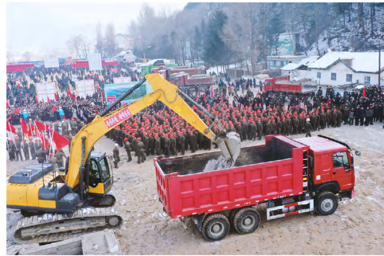
金正淑郡地方工业工厂建设开工典礼
